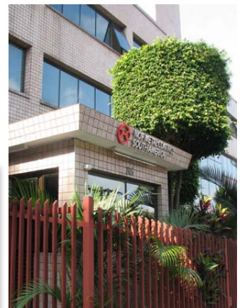
Fig 1. NOF SA Industrial Plant
